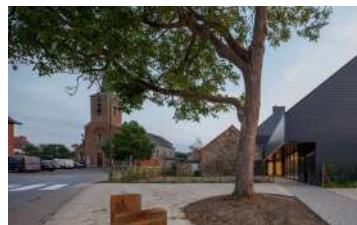
Blanmont , construction de deux logements et d'une bibliothèque (photo AAMathen) Centralité villageoise
