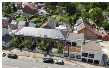
Fleurus , réaffectation et extension d'une école (photo SPW 2025) Centralité villageoise
