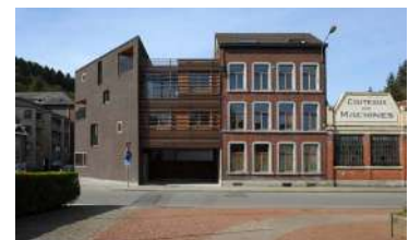
Dison , rénovation et construction de logements publics (photo Olivier Fourneau Architecte) Centralité urbaine de pôle
