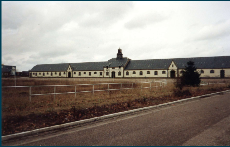
Ancienne caserne Bridoux reconvertie en campus universitaire (Metz)
