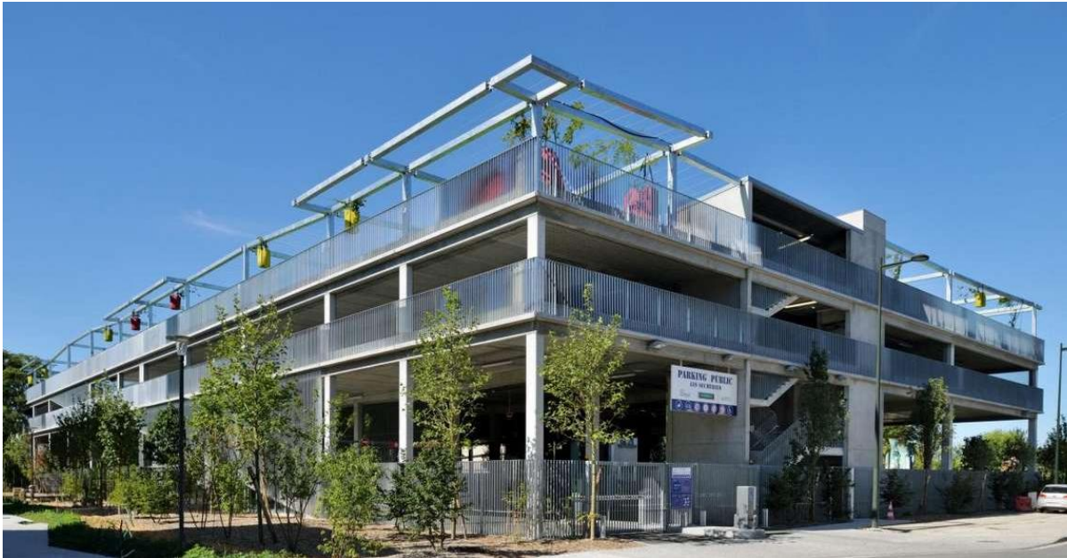
Bègles : Parking en ouvrage conçu pour accueillir des manifestations
