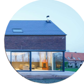
Maison unifamiliale Braffe Intérêt en matière d'aménagement du territoire ?
