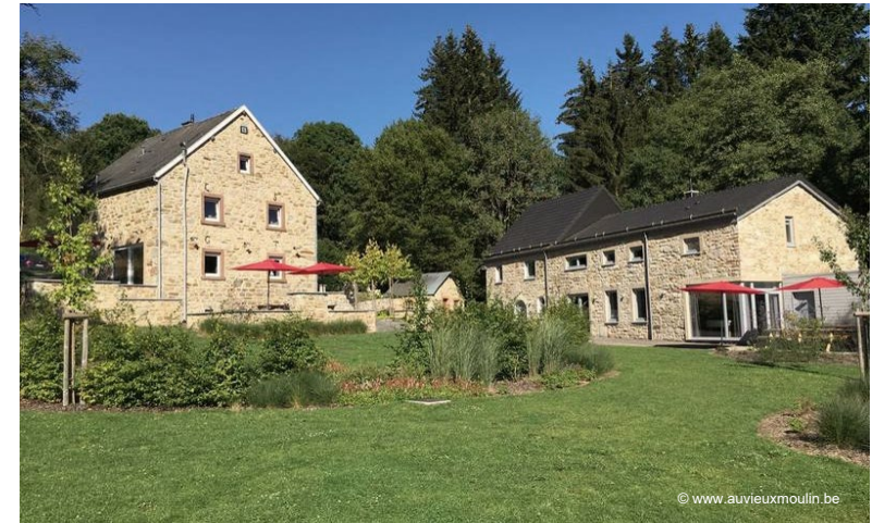
Au Vieux Moulin (Airbnb) Ancien moulin, 24 lits touristiques Thirimont-lez-Waimes
