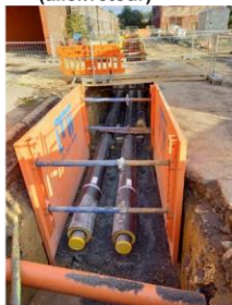
3. Un réseau de tuyaux enterrés (aller/retour)
