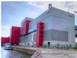
1. Une source de chaleur : UVE de Intradel-Uvelia + back-up
