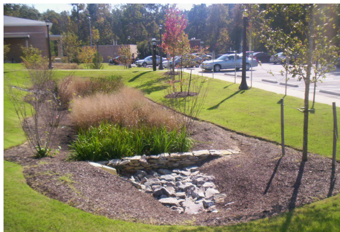
Figure 4: Jardin de pluie d'infiltration. Source : W&M Rain Garden
