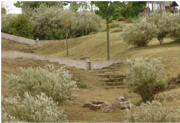
Figure 9: Noue en pente scindée en plusieurs biefs par des murets formant un barrage avec un dispositif de vidange dans le quartier du Kronsberg, Hanovre, Allemagne. Source photo: Valérie Mahaut
