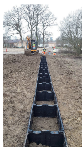
Figure 6: Installation d'une rangée d'échelles d'eau dans le domaine public. Source : EFOH
