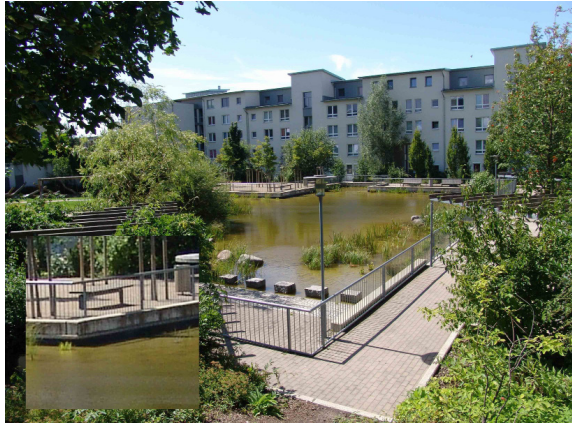
Figure 4 : Bassin en eau de rétention. Ce grand étang de forme plus géométrique permet un marnage de quelques dizaines de centimètres de haut. On le remarque à la géo-membrane qui dépasse de manière peu élégante de la surface de l'eau. Quartier du Kronsberg, Hanovre. Photo Valérie Mahaut.
