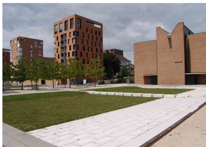
Figure 12: Bassin sec devant l'école du quartier Scharnhäuserpark, Stuttgart, Allemagne. Les eaux de pluie de la toiture s'écoulent librement dans une partie revêtue à l'entrée du bassin. Photographie: Valérie Mahaut
