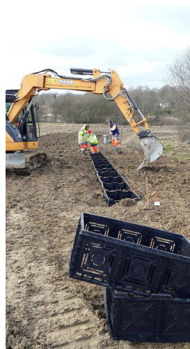
Figure 6: Installation d'une rangée d'échelles d'eau dans le domaine public. Source : EFOH
