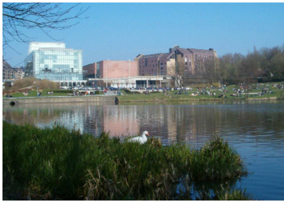
Figure 6 : Lac de rétention de Louvain-la-Neuve qui reçoit les eaux de pluie du réseau séparatif de la ville neuve. L'évacuation des eaux stockées sont déversées à débit régulé dans un ruisseau affluent de la Dyle. Photo Valérie Mahaut.
