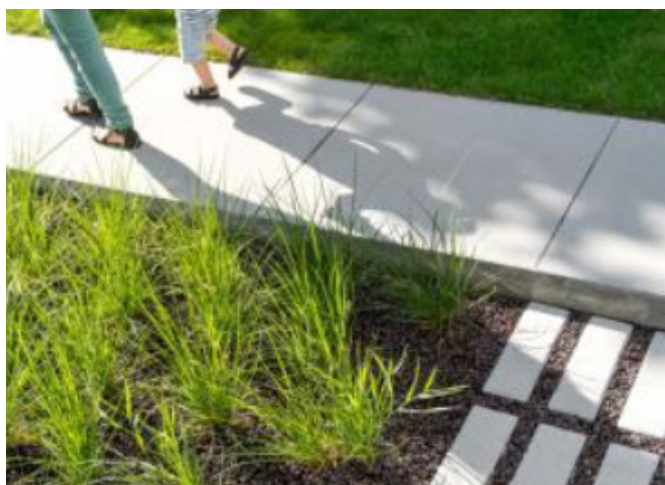
Figure 8 : Pavements à larges joints. Sources : Ebema Stone & Style
