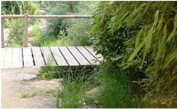
Figure 3: Petit fossé à berges en rochers et à fond de gravier. Lotissement Arkadien à Asperg (Stuttgart). Source photo: Valérie Mahaut
