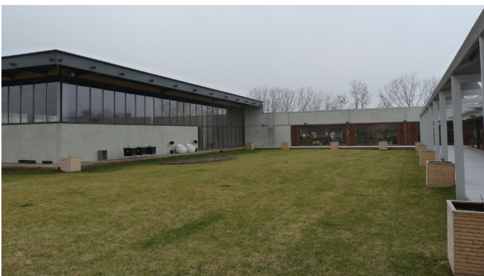
Figure 7: Toiture stockante végétalisée - semi-intensive sur le magasin Caméléon - Source: Catherine Massart
