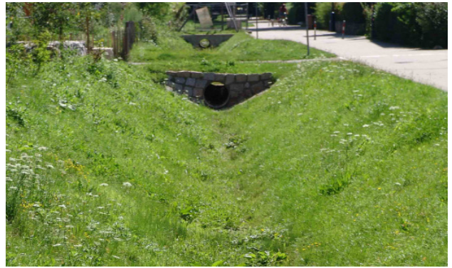
Figure 4: Long fossé avec connexion des différents biefs, quartier Vauban à Fribourg-en-Brisgau, Allemagne. Source photo: Valérie Mahaut
