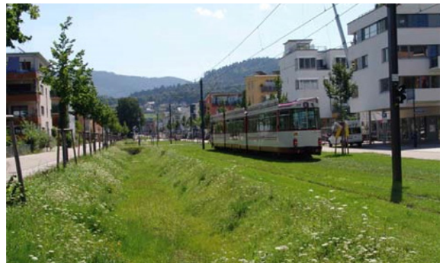
Figure 6: Noue en pente scindée en plusieurs biefs par des murets formant un barrage avec un dispositif de vidange dans le quartier du Kronsberg, Hanovre, Allemagne. Source photo: Valérie Mahaut
