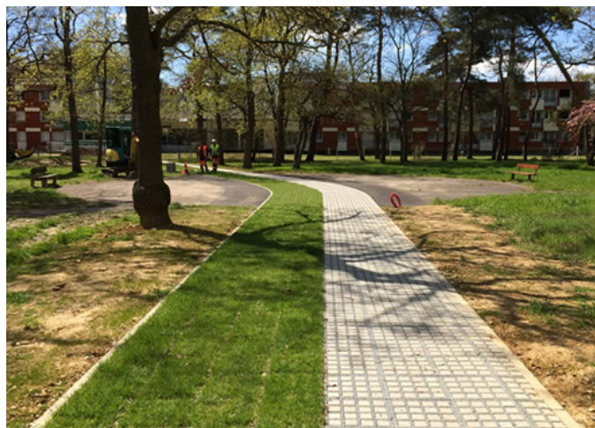
Figure 4 : Accès pompiers gazon et pavés ou chemin de promenade : une double fonction pour cette résidence Séniors. Source : o2d-environnement
