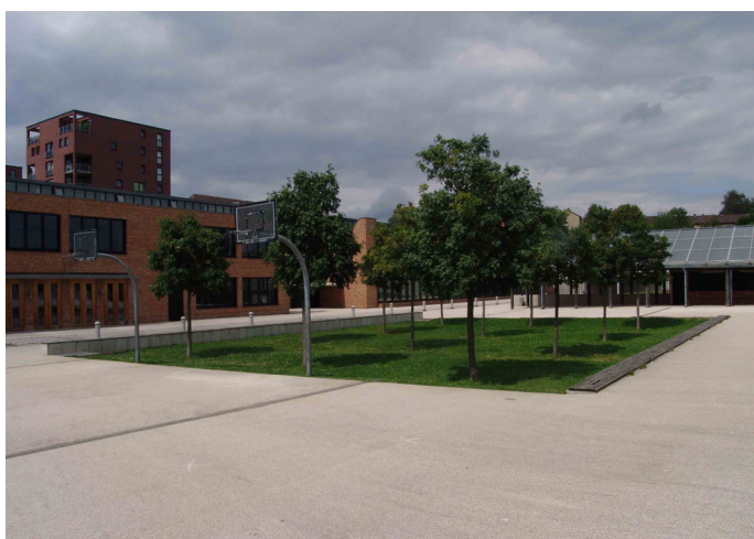
Figure 11: Bassin sec dans la cour de récréation de l'école du quartier Scharnhäuserpark, Stuttgart, Allemagne Photographie: Valérie Mahaut
