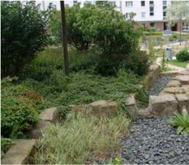
Figure 17 - Tranchée de courte longueur, sans revêtement superficiel. Quartier du Kronsberg, Hanovre. Photo Valérie Mahaut. Source : Architecture & Climat. Source : Architecture & Climat.
