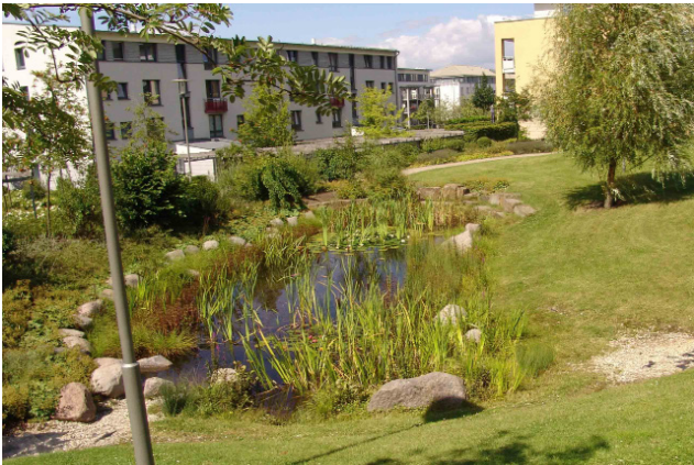
Figure 3 : Bassin en eau mixte: la ligne des pierres situe le bord de la géo-membrane imperméable qui garantit une lame d'eau permanente dans ce bassin. Par forte pluie, le niveau de l'eau monte et déborde du bord imperméable : l'eau peut alors s'infiltrer dans le sol des berges engazonnées. Quartier du Kronsberg, Hanovre. Photo Valérie Mahaut.
