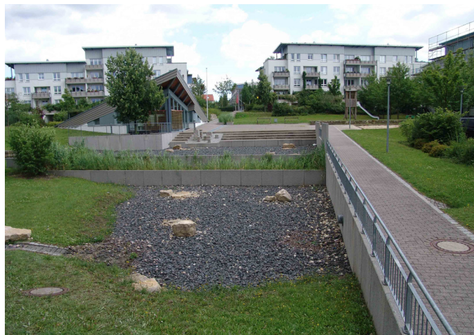
Figure 8: Bassin sec minéralisé en gravier, quartier du Kronsberg, Hanovre, Allemagne Photographie: Valérie Mahaut
