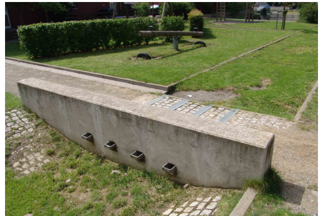
Figure 10: Noue infiltrante à revêtement pavé à joints non cimentés, barrée par un mur de soutènement reliant cette noue à la suivante par un dispositif de trop-plein. Quartier du Kronsberg, Hanovre. Source photo: Valérie Mahaut
