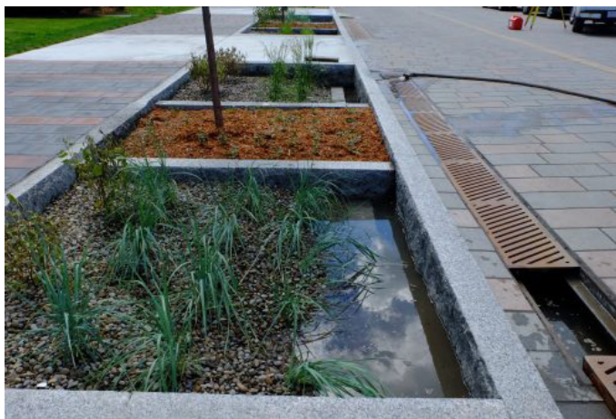
Figure 3: Nœud en pente scindée en plusieurs biefs par des murets formant un barrage avec un dispositif de vidange dans le quartier du Kronsberg, Hanovre, Allemagne. Source photo: Valérie Mahaut
