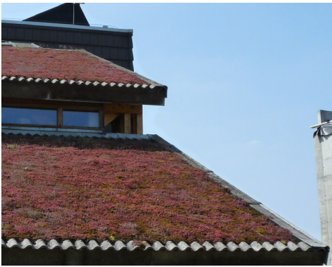
Figure 7: Toiture stockante végétalisée - semi-intensive sur le magasin Caméléon - Source: Catherine Massart
