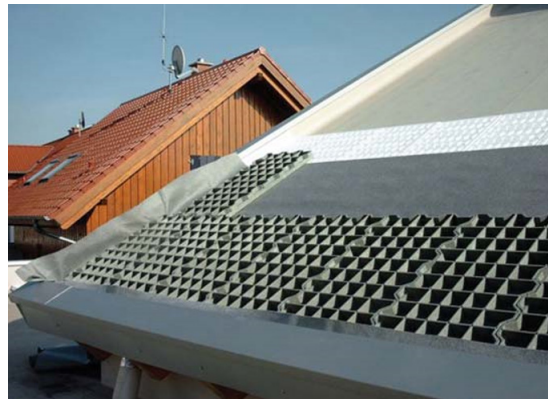
Figure 8: baquets de rétention de substrat pour la réalisation d'une toiture stockante inclinée - Source: Note d'information technique 229 du CSTC
