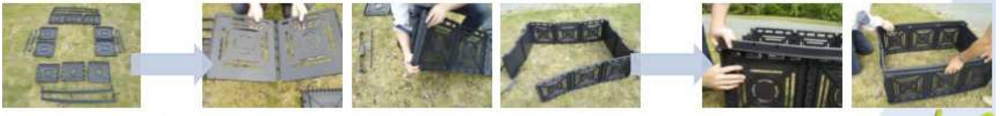
Figure 9: Etapes de montage d'une échelle d'eau. Ce montage ne nécessite pas de connaissances particulières ni d'outils - Source: www.efoh.fr
