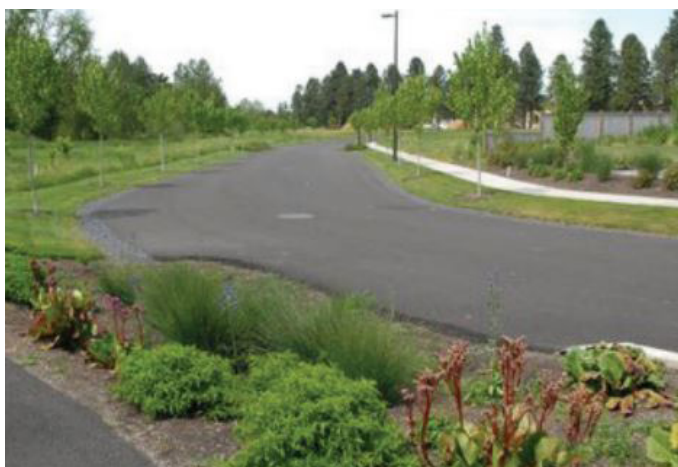
Figure 2: Bande filtrante le long d'un chemin carrossable - Source:
