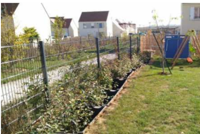
Figure 4: Installation d'une rangée d'échelles d'eau dans un jardin privé, le long de la clôture - source: http://www.forest.irisnet.be/fr/services-communaux/gestion-de-leau/fichiers/fiche-technique-2-25-01-2018-fr.pdf
