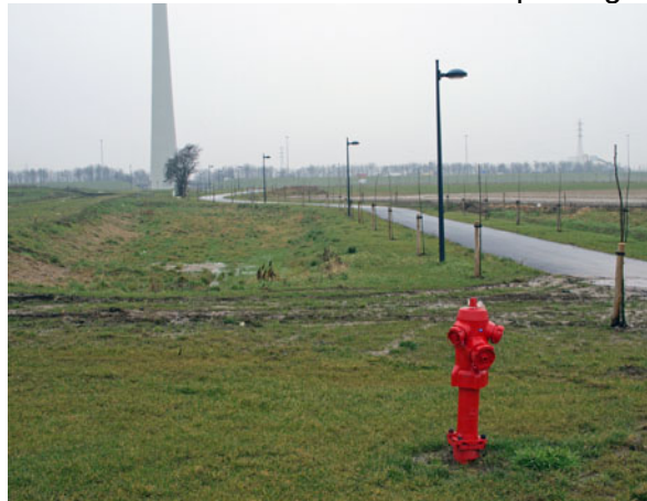
Installation de noues en bord de voirie
