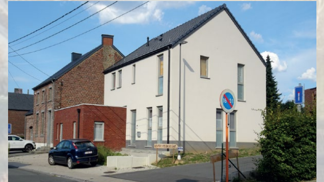
5. Maison + logement kangourou
