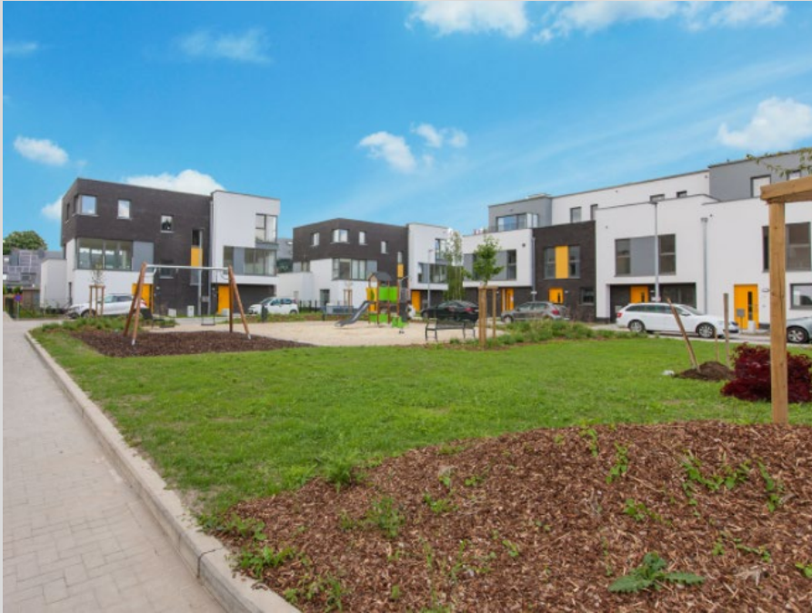
Développeur : Thomas & Piron Architecte : BAEB
