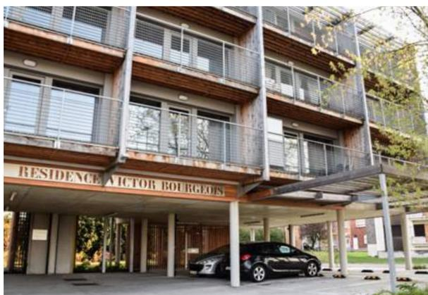
Montignies-sur-Sambre – Dans le cadre de la réhabilitation de la 'Cité du Centenaire', un bâtiment offrant 12 logements adaptables a été construit sur pilotis. Cette configuration permet aux PMR de garer leur véhicule au plus près de leur logement et d'y accéder facilement via un ascenseur.
