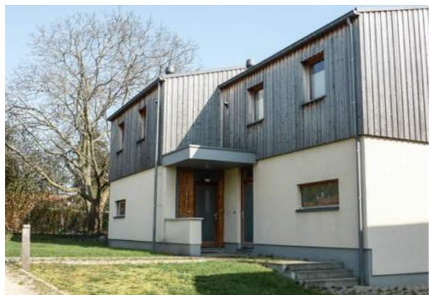
**Liège** – Dans le quartier 'Green Tilleur', les matériaux ont été choisis pour leurs performances thermiques (K23). La structure du bâtiment est en ossature bois. Les murs sont composés d'un béton de chanvre couvert d'un enduit et d'un bardage en bois.
