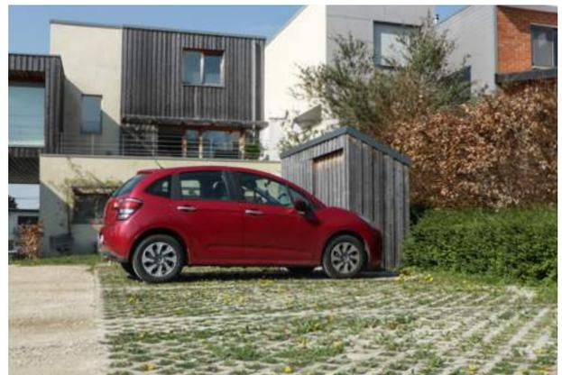
**Liège** – Le projet 'Green Tilleur' bénéficie d'une aire de stationnement perméable grâce à des dalles de béton engazonnées.
