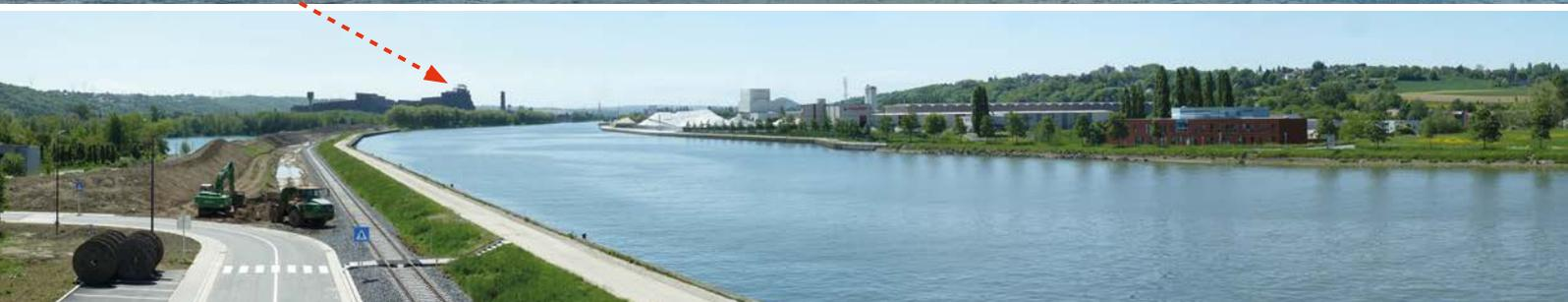
Le site sidérurgique de Chertal, composé d'une aciérie et de laminoirs, est implanté sur une bande de terrain séparant la Meuse et le canal Albert, en aval de Liège. Mis en place dans les années 1960, le site est aujourd'hui à l'arrêt. On y transformait en bobines de tôle en acier (ou « coils ») la fonte produite dans les hauts fourneaux d'Ougrée et de Seraing et transportée à Chertal par wagons spéciaux.
