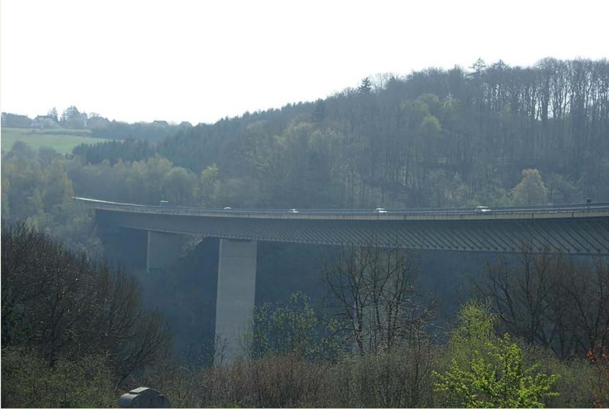
Construit de 1979 à 1981, le viaduc Charlemagne permet à la voie rapide N97 de traverser la vallée de la Meuse en amont de Dinant. D'une longueur de 642 mètres, il surplombe la Meuse à septante mètres et enjambe l'île d'Amour, l'île de Moniat et les carrières du Pénant.
