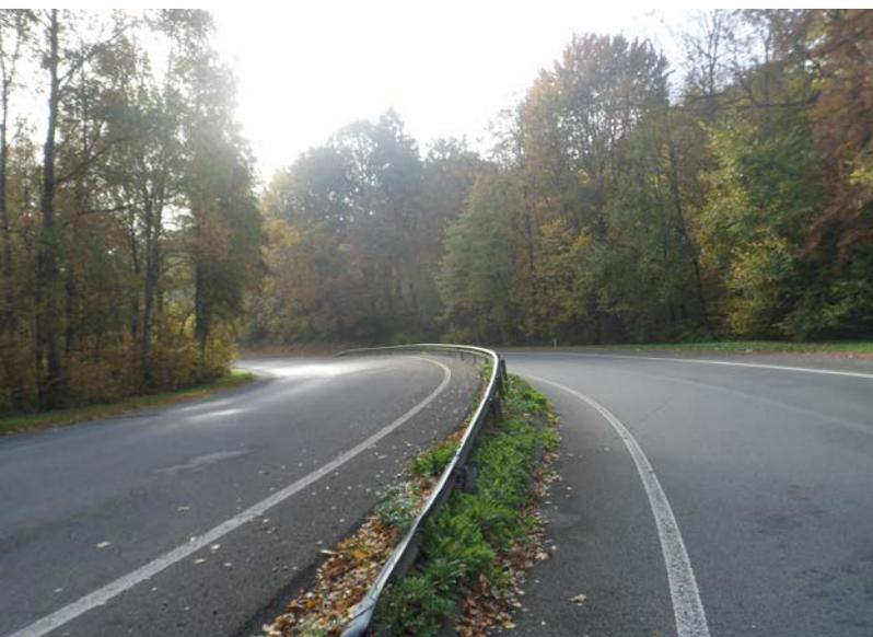
Toujours du fait du relief, la largeur de la voirie a nécessité une différence de niveau entre les deux bandes de circulation afin de rattraper la dénivellation.
