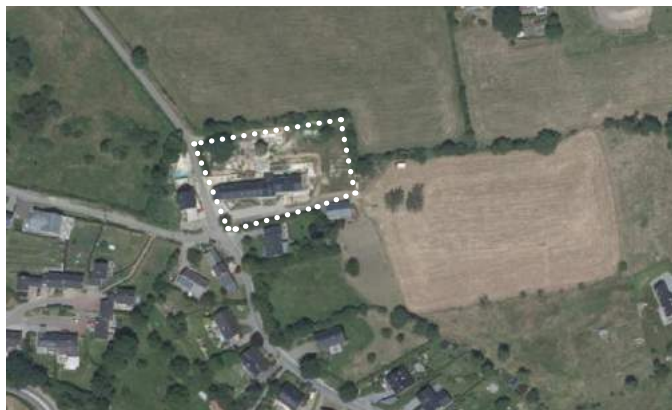
Situation : Rue Dessus-le-Bois
