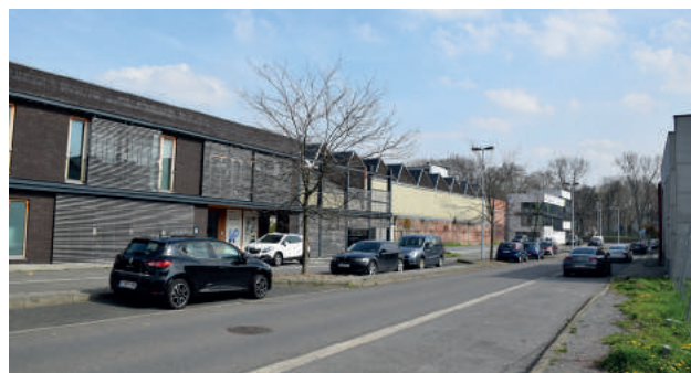
Rue de la cablerie sur le site Pieper (Liège)
