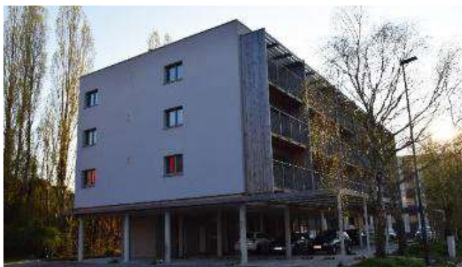
Ce bâtiment construit sur pilotis offre 12 logements adaptables. Cette configuration permet aux PMR de garer leur véhicule au plus près de leur logement et d'y accéder aisément via un ascenseur
