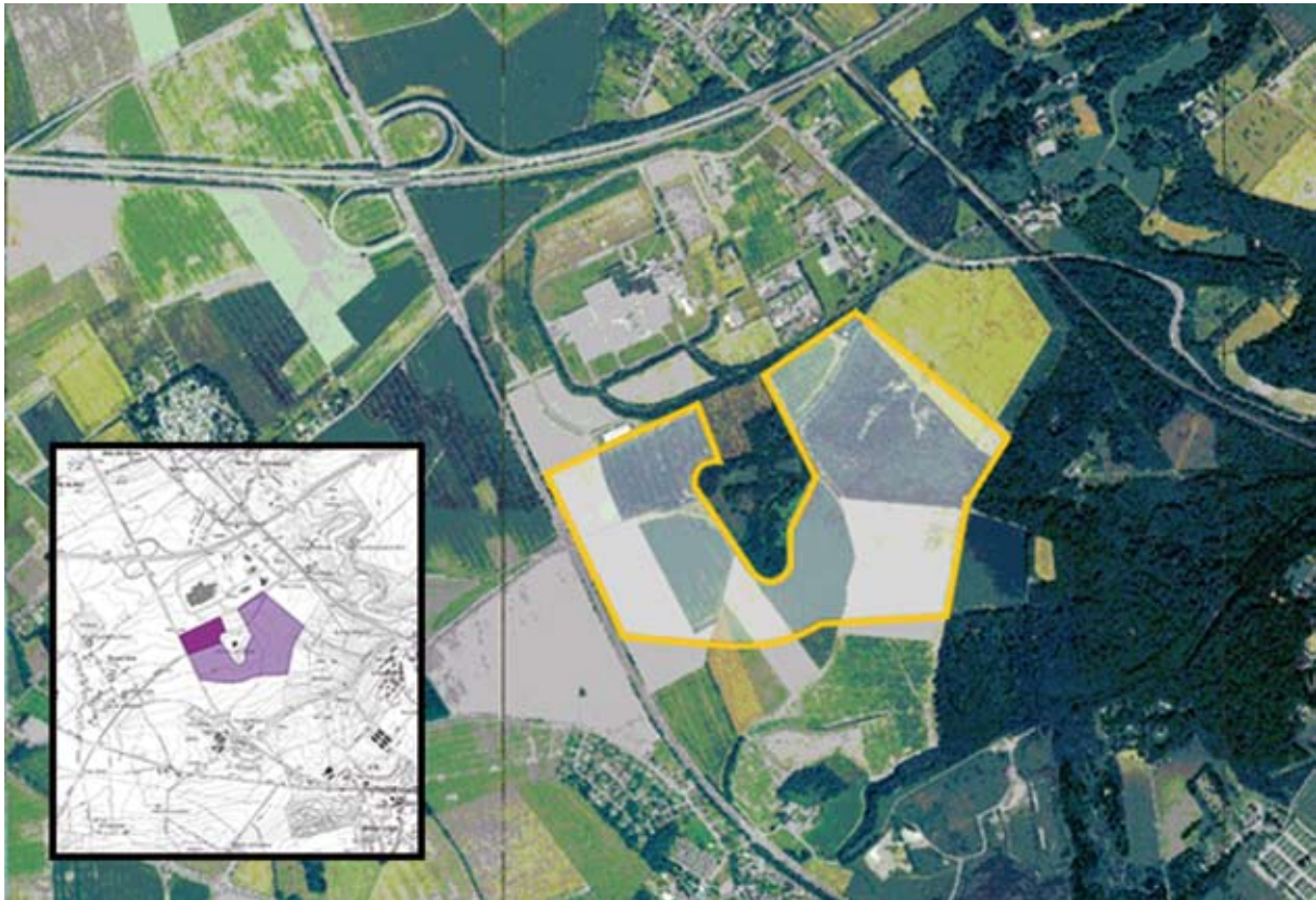
Projet d'une zone d'activité économique mixte et d'une zone d'activité économique industrielle à Namur (Rhisnes et Suarlée), en extension de la zone d'activité économique de Namur-nord. Photo SPW – 2004
