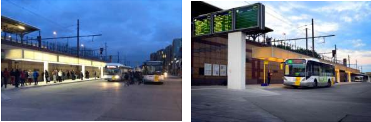
Photos 4 : Le pôle bus de la gare d'Alost (source : Solico & Bureau d'ingénierie des structures Util).
