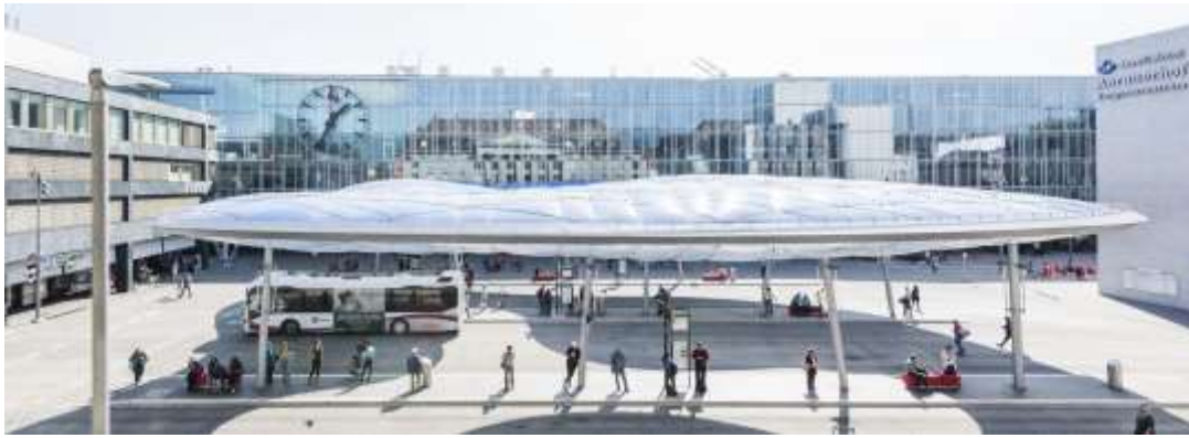
Figure 37 : La gare d'Aarau, labellisée "Gare Plus" (source : https://www.sbb.ch/fr/gare-services/gares/gare-de-aarau.html ).
